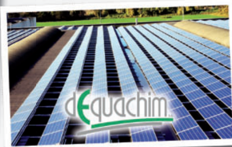
Dequachim : Installation de 200 kWc, soit 800 panneaux
