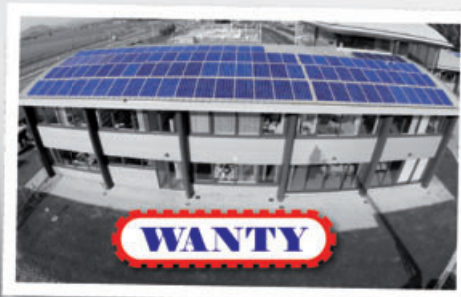
Wanty : Installation de 159 kWc, soit 636 panneaux
