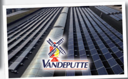
Vandeputte : Installation de 500 kWc, soit 2000 panneaux
