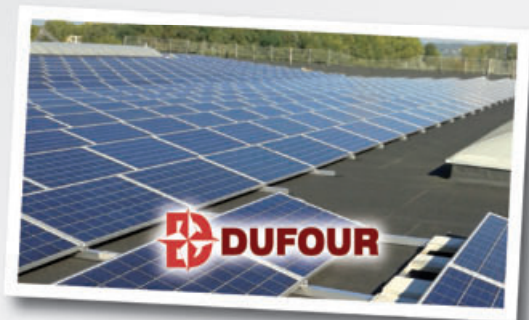
Dufour : Installation de 500 kWc, soit 2000 panneaux
