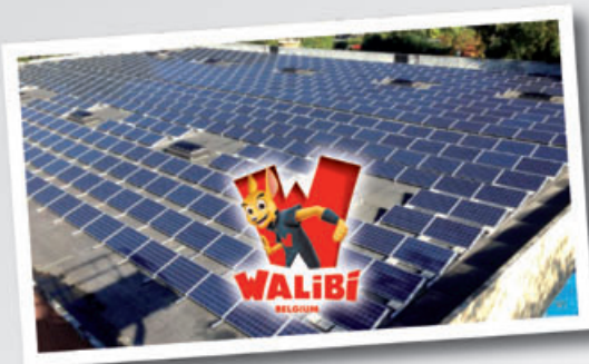
Walibi : Installation de 250 kWc, soit 1000 panneaux
