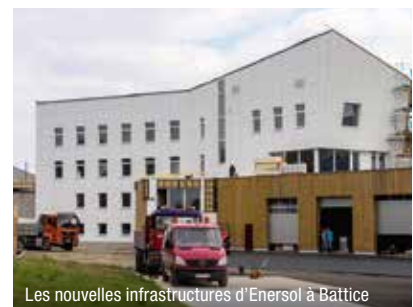
Les nouvelles infrastructures d'Enersol à Battice
