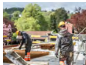
Un chantier de la société Eloy
